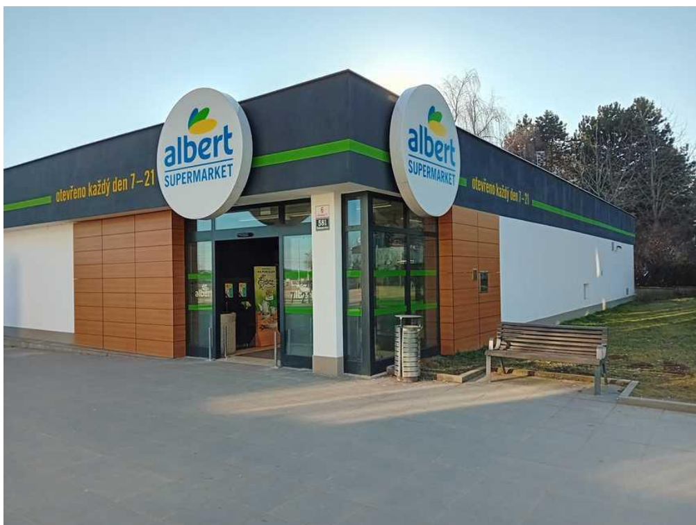
severovýchodní pohled na parcelu č. 1548/1, k.ú. Kohoutovice se stavbou č.p. 581
